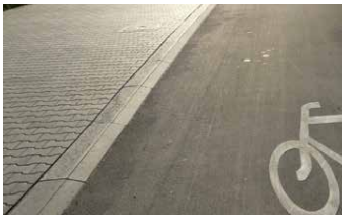
Zdjęcie 17 Obniżenie drogi dla rowerów względem chodnika przy pomocy krawężnika utożonego „na płask”. Wrocław, Polska
