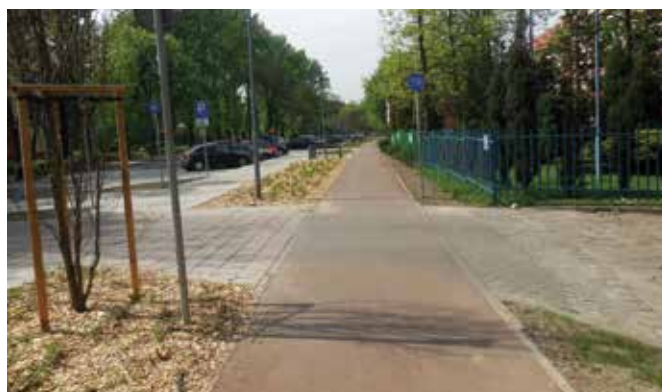
Zdjęcie 20 Ciągłość nawierzchni drogi dla rowerów przez zjazd. Sosnowiec, Polska
