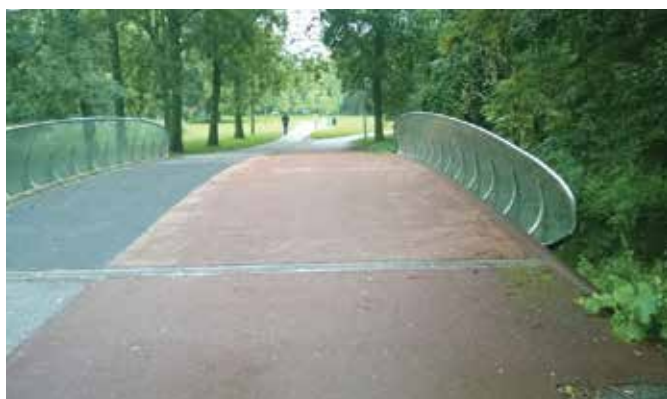
Zdjęcie 63 Kładka z barierą łukową. Amsterdamski kanał, Holandia
