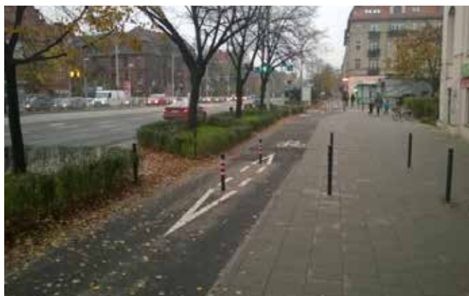
Zdjęcie 69 Słupki blokujące dwukierunkową drogę dla rowerów przed wjazdem samochodów. Wrocław, Polska
