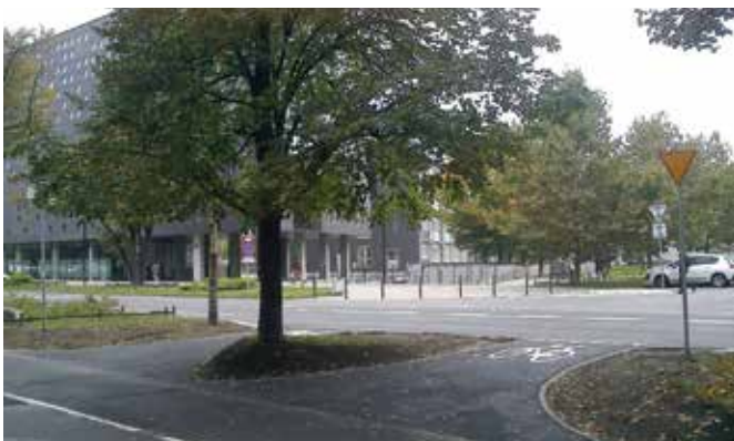
Zdjęcie 39 Czwarty wlot rowerowy na skrzyżowanie typu T – odseparowany wjazd i zjazd. Wrocław, Polska
