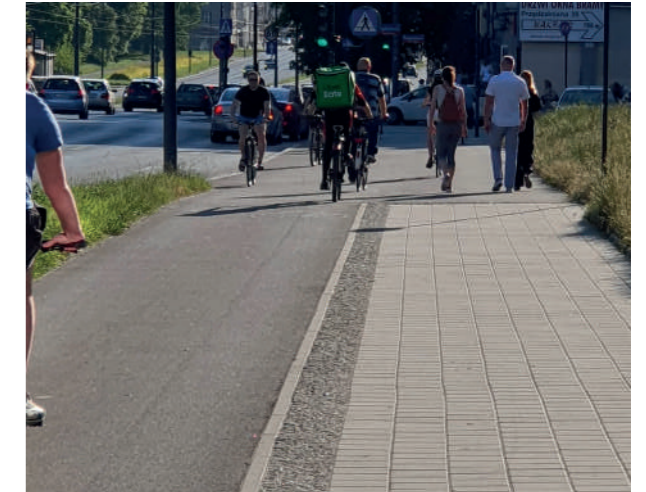
Zdjęcie 17 Separacja drogi dla rowerów względem chodnika przy pomocy zabruku z kamienia łupanego (brak zalecanej różnicy poziomów). Łódź, Polska
