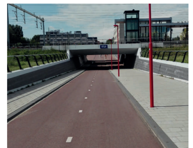
Zdjęcie 39 Wzorcowy tunel rowerowy łączący Houten z Utrecht. Łagodny spadek, podniesiona niweleta linii kolejowej, ściany rozchylające się ku górze, świetliki, wydzielona przestrzeń dla pieszych. Holandia
