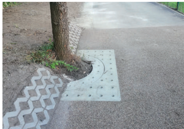
Zdjęcie 43 Perforowana płyta betonowa w nawierzchni drogi dla rowerów zabezpieczająca nawodnienie bryły korzeniowej oraz ochronę nawierzchni drogi dla rowerów. Wrocław, Polska
