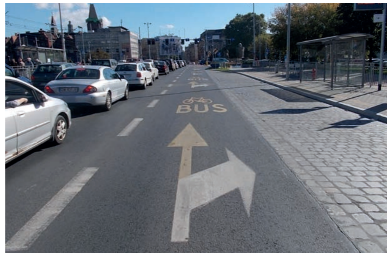
Zdjęcie 19 Bus pas z dopuszczonym ruchem rowerowym. Wrocław, Polska
