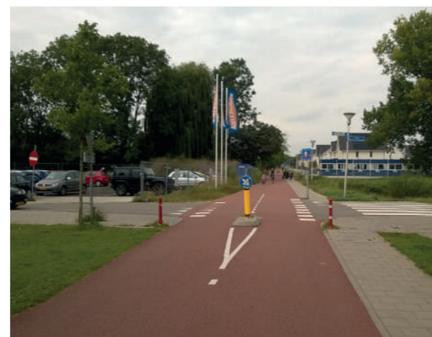
Zdjęcie 44 Słupki blokujące dwukierunkową drogę dla rowerów przed wjazdem samochodów. Nijmegen, Holandia
