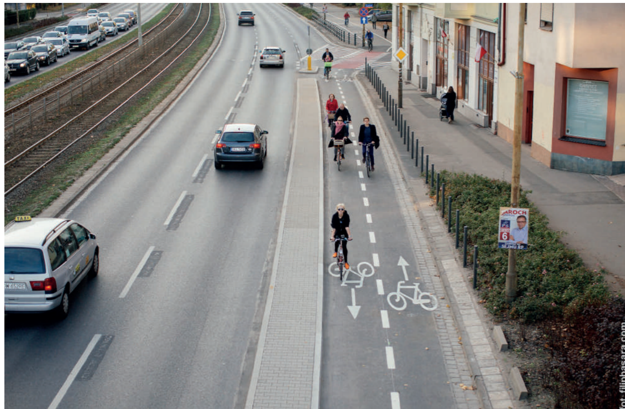
Zdjęcie 10 Droga dla rowerów wydzielona z jezdni. Wrocław, Polska
