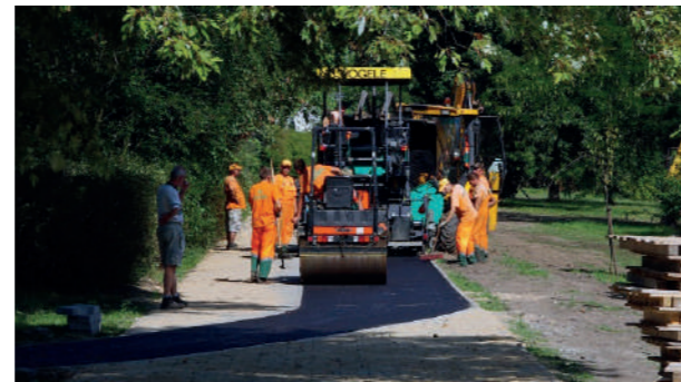
Zdjęcie 13 Rozkładanie warstwy ścieralnej przy wykorzystaniu rozściełacza. Łódź, Polska
