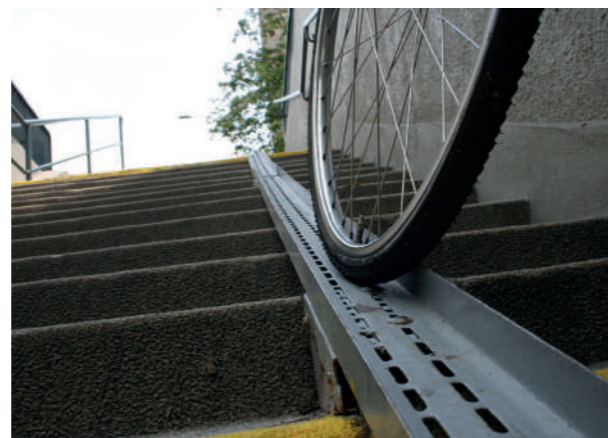
Zdjęcie 40 Szyny na schodach umożliwiające prowadzenie roweru. Opole, Polska
