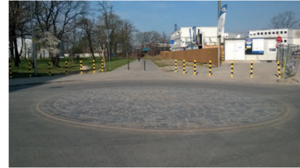
Zdjęcie 5 Wlot dwukierunkowej drogi dla rowerów na małe rondo. Wrocław, Polska
