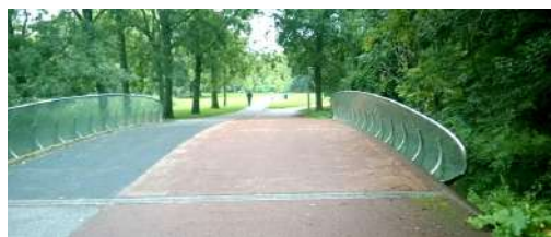
ZDJĘCIE 59. Holandia, Amsterdam. Łukowa bariera zwiększająca szerokość użyteczną kładki.
