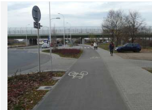
ZDJĘCIE 19. Polska, Wrocław. Ciągłość nawierzchni drogi rowerowej na przecięciu z jezdnią/zjazdem.
