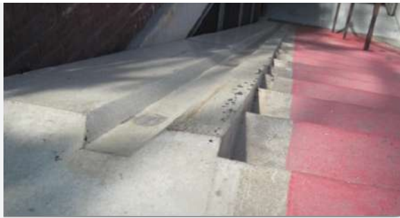
ZDJĘCIE 57. Holandia, Zwolle. Rampa do wprowadzania rowerów.
