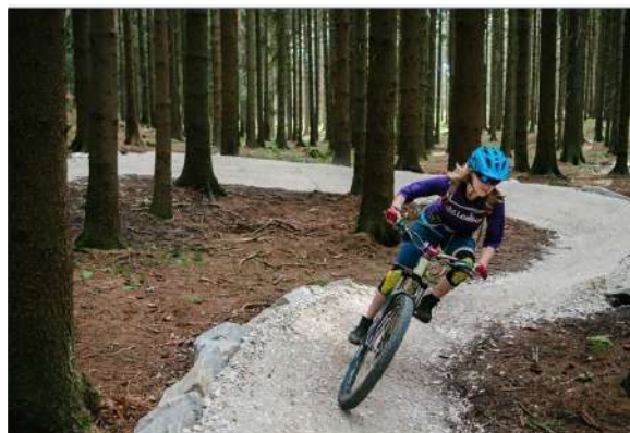
ZDJĘCIE 84. Wyprofilowane zakręty (tzw. bandy).
