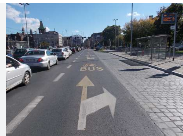
ZDJĘCIE 26. Polska, Wrocław. Pas ruchu do skrętu w prawo z dopuszczonym ruchem rowerowym na wprost.
