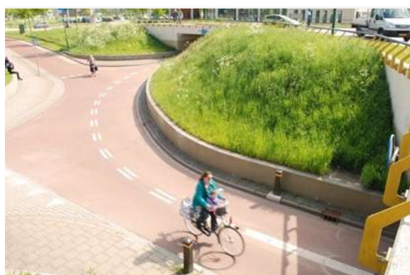
ZDJĘCIE 46. Holandia, Houten. Rondo wielopoziomowe.
