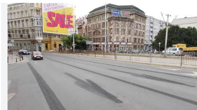
ZDJĘCIE 24 Polska, Wrocław. Usuwanie oznakowania poziomego wodą pod ciśnieniem.
