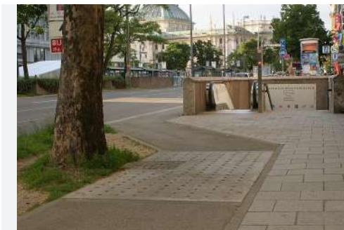
ZDJĘCIE 20. Niemcy, Berlin. Płyta betonowa z otworami przykrywająca system korzeniowy.
