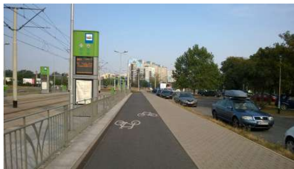
ZDJĘCIE 17. Wrocław. Nawierzchnia ścieralna drogi dla rowerów.
