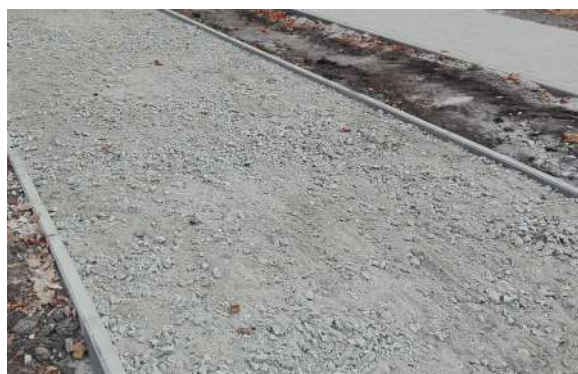
ZDJĘCIE 18. Wrocław. Podbudowa drogi dla rowerów.
