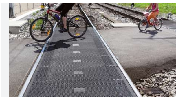
ZDJĘCIE 42. Bezrowkowy przejazd rowerowy przez linię kolejową:
